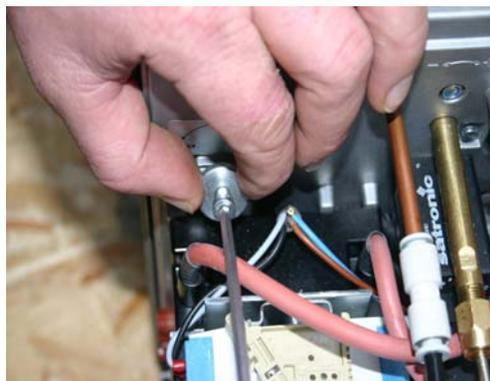
Je nach Bedarf der Verbrennungsluft in Bezug auf die Messdaten- Luftklappe öffnen oder schließen.
