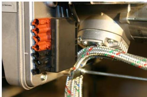
Ölschläuche mit Klemmbügel, der sich unten am Brennergehäuse befindet, mit vorhandenem Inbusschlüssel (4 mm) lösen und Ölschläuche in die Führung einlegen und festziehen.
