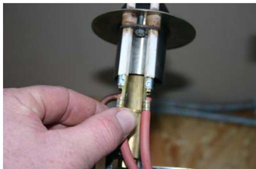
Zündkabel von den Zündelektroden abziehen.
