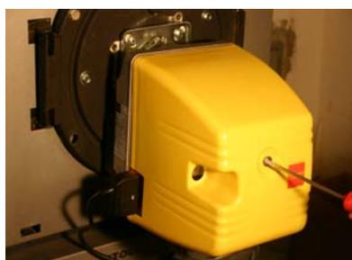
C1P-Brennerhaube aufsetzen und mit Befestigungsschraube fixieren.
