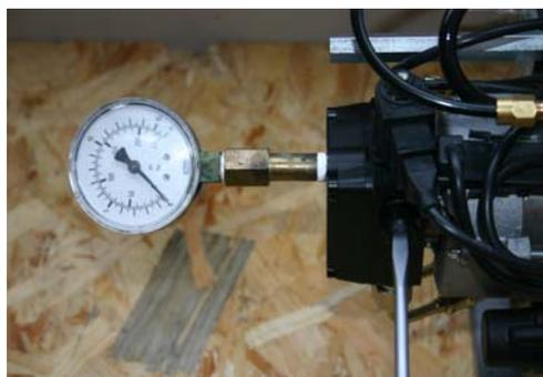
Parallel zum Einstellen der Leistung und Messdaten, wird die Druckverstellung an der Suntec-Ölpumpe vorgenommen.
