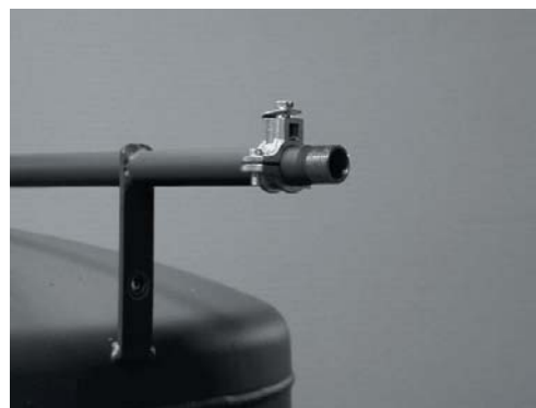
Bild 5-4: Erdungsschelle
