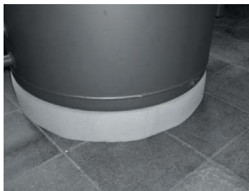
Bild 5-5: Isolierung Speicherfuß
